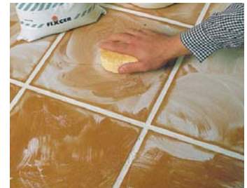
Realizați o curățare uscată
