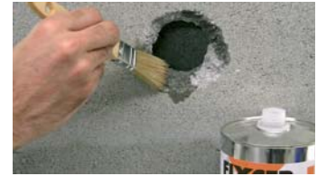
Impregnați betonul cu IMPRIMACIÓN.
