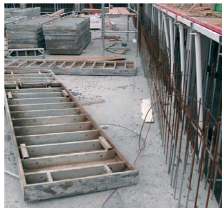
Introduceți FUGA-STOP și turnați betonul între cofraje.
