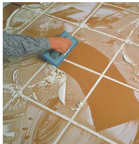
Etanșarea rosturilor din suprafața piscinelor.
