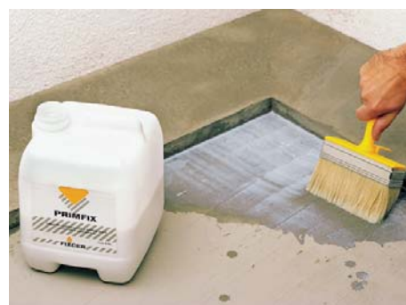
Cu PRIMFIX grunduim suprafețele absorbante.
