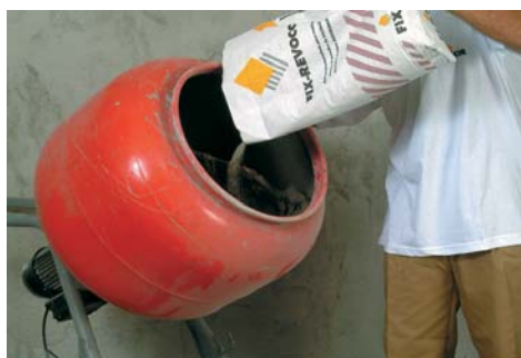
Mortar cu o consistență "plastică"
