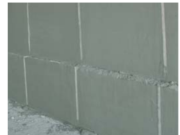
Nivelați între marmorii de ghidare.
