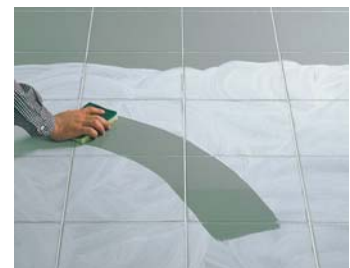
Realizați o curățare uscată
